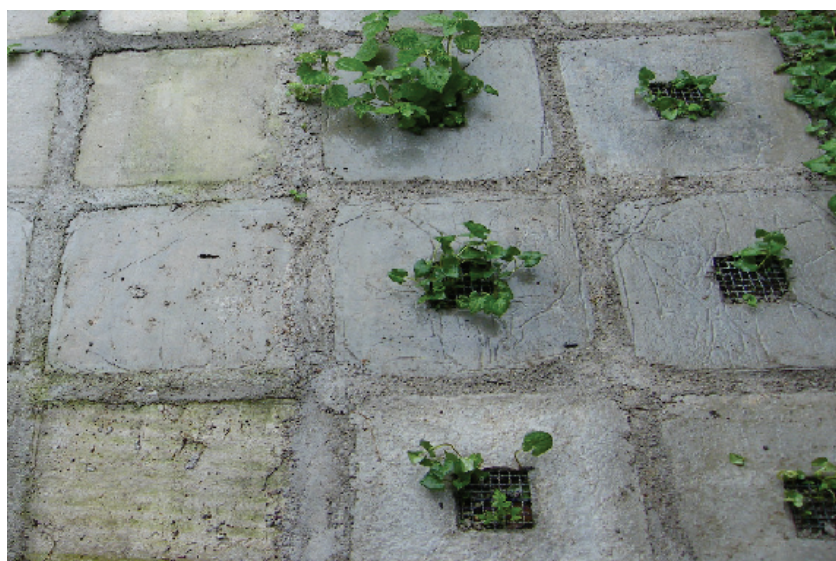
図5. 2009年に度防御材を設置した法面保護の例
