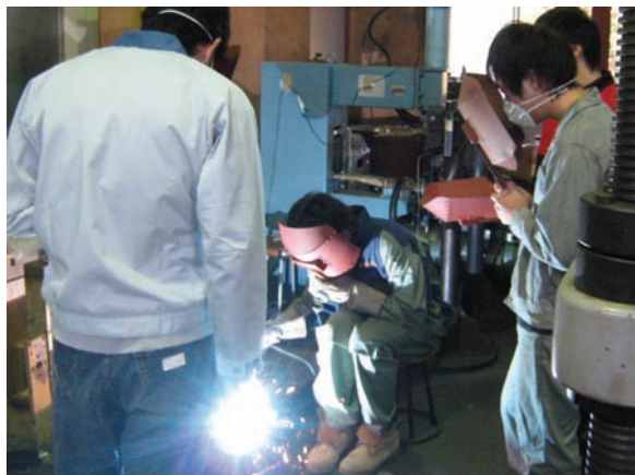
資料1 受講学生による梁の製作実習の様子 溶接作業（上），切断作業（下）
